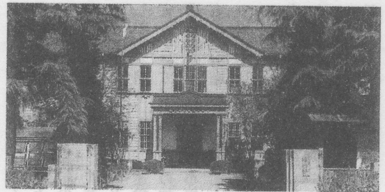
旧本庄高等女学校「本館」
